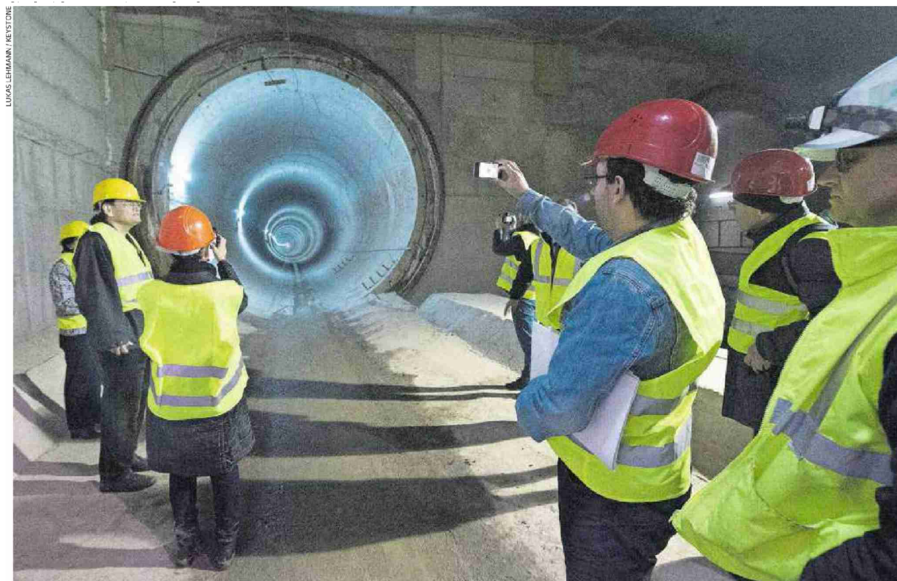
Unterstützt mit Geldern aus der Schweiz: Baustelle zur Erweiterung des U-Bahn-Netzes in Bukarest, Rumänien. (23. 3. 2015)
